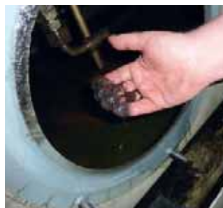
Dieses Öl ist unübersehbar mit Feststoffen verschmutzt. Dafür braucht man (fast) keine Analyse.
